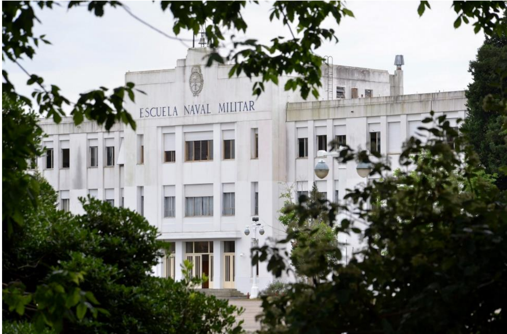
La actual sede: su estilo arquitectónico.
