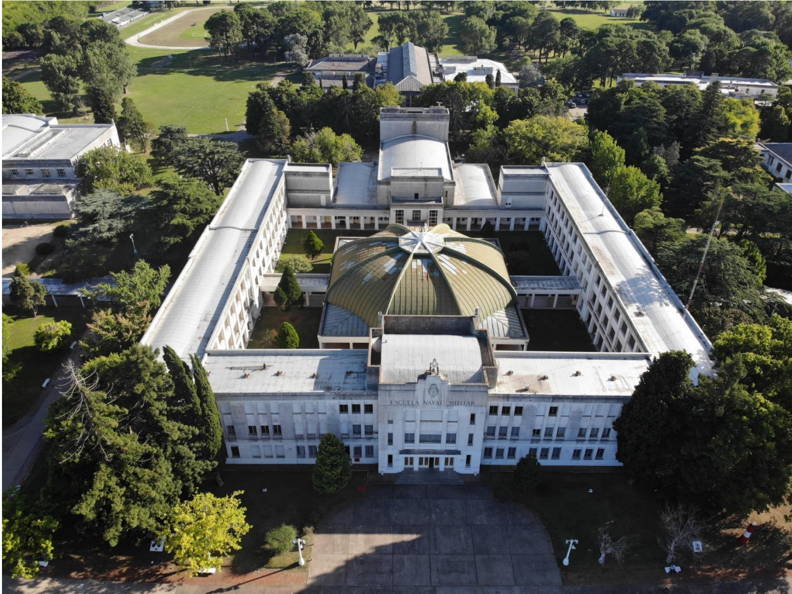
Edificio de estudios. Sede Río Santiago.
